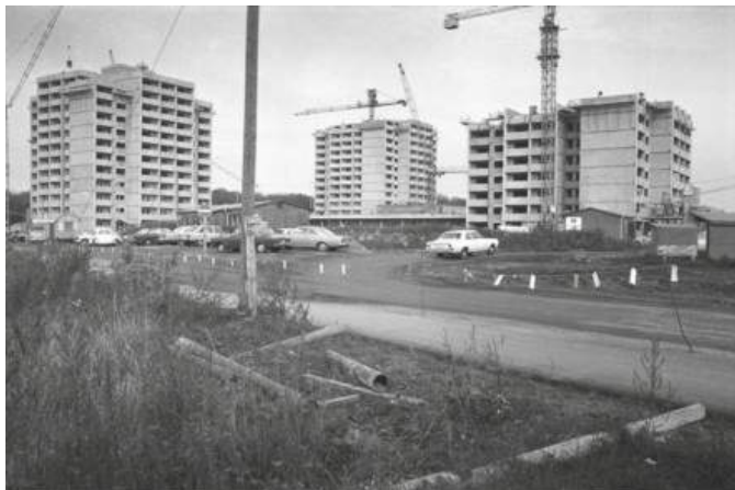
die Hochhäuser des Wohnstifts in Bau
